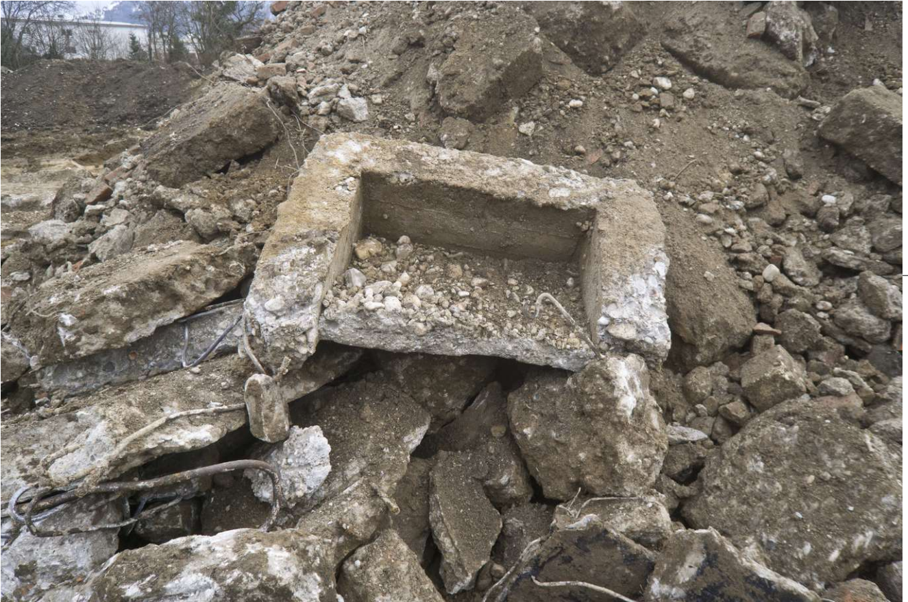
Abbildung 11 Oben: Detailaufnahme des aus dem Keller geborgenen Überrests der mutmaßlichen Kohleschütte, über die von außen das Brennmaterial in den Keller verfrachtet werden konnte. Der auf den ersten Blick eher als Treppenstufe einzuschätzende Betonbrocken liegt hier auf dem Kopf und war mit einer deutlichen Neigung angefertigt worden, eine Treppe dürfte daher ausscheiden.
