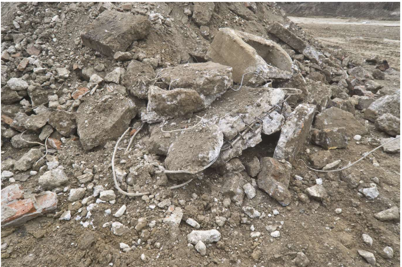
Abbildung 9 Detailaufnahme der aus dem Keller geborgenen Teile der mit fingerdicken Armieisen bewehrten Stahlbetondecke des Kellers. ©Rinser; X-Cavate Archaeology
