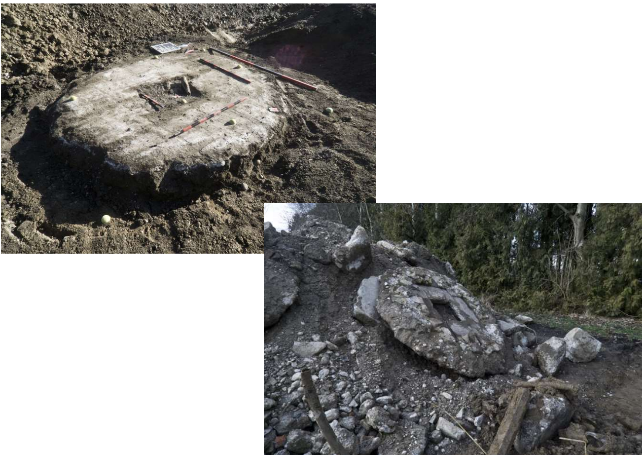
Abbildung 14 Aufnahmen des runden Betonpodest nach Auffindung sowie nach dessen Abriss. Das gerade einmal rund 30 Zentimeter mächtige Fundament wäre für eine FLAK vermutlich unterdimensioniert gewesen.
