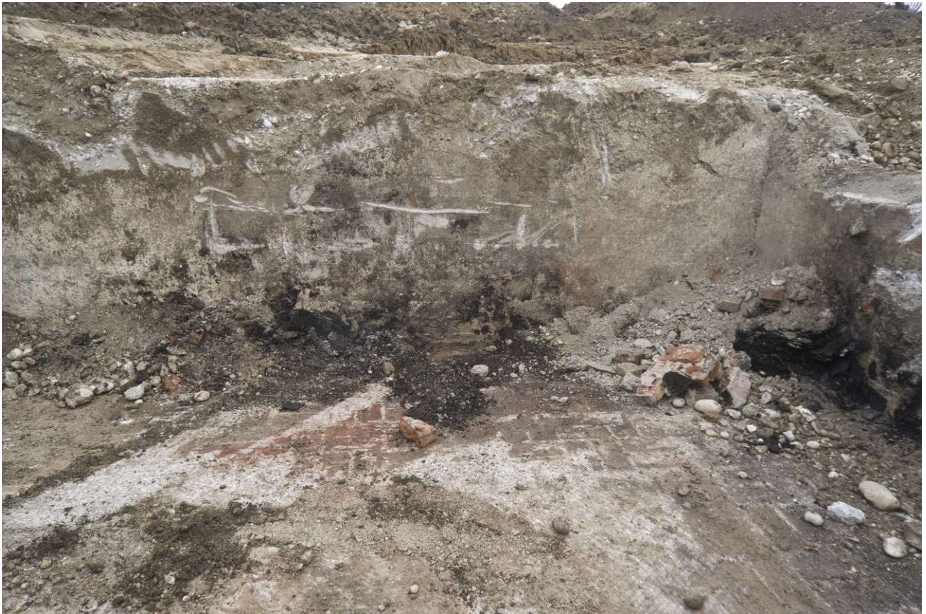
Abbildung 12 Detailaufnahme der teilweise verrußten und mit einer bitumenartigen Substanz überzogenen Kellerwände im Südraum. Über dem Ziegelboden der Räume war ein Estrich angebracht worden. In der südwestlichen Ecke fanden sich noch die Überreste von schollenartig zusammenklebenden Bitumen- oder Teerresten sowie Teile eines gemauerten Kamins. Oberhalb in der gleichen Ecke sind die Reste der postulierten Kohleschütte erkennbar. Insgesamt könnte es sich hierbei um einen Heizungsraum gehandelt haben. ©Rinser; X-Cavate Archaeology
