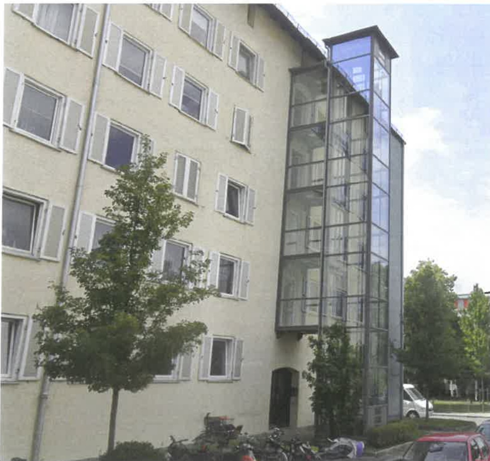
Abb. 4 Beispiel einer Aufzugsnachrüstung mit Halt an den Zwischenpodesten
