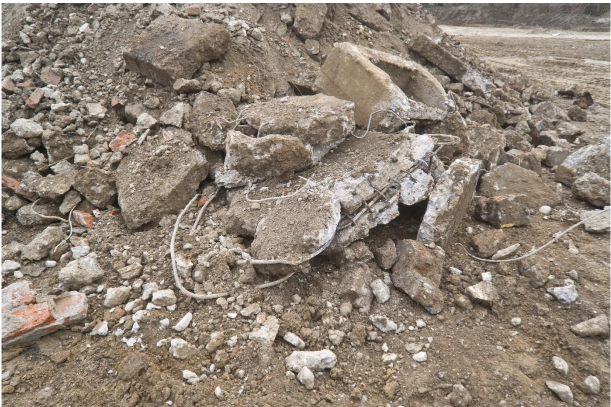
Abbildung 5: Detailaufnahme der aus dem Keller geborgenen Teile der mit fingerdicken Armiereisen bewehrten Stahlbetondecke des Kellers. ©X-Cavate Archaeology
