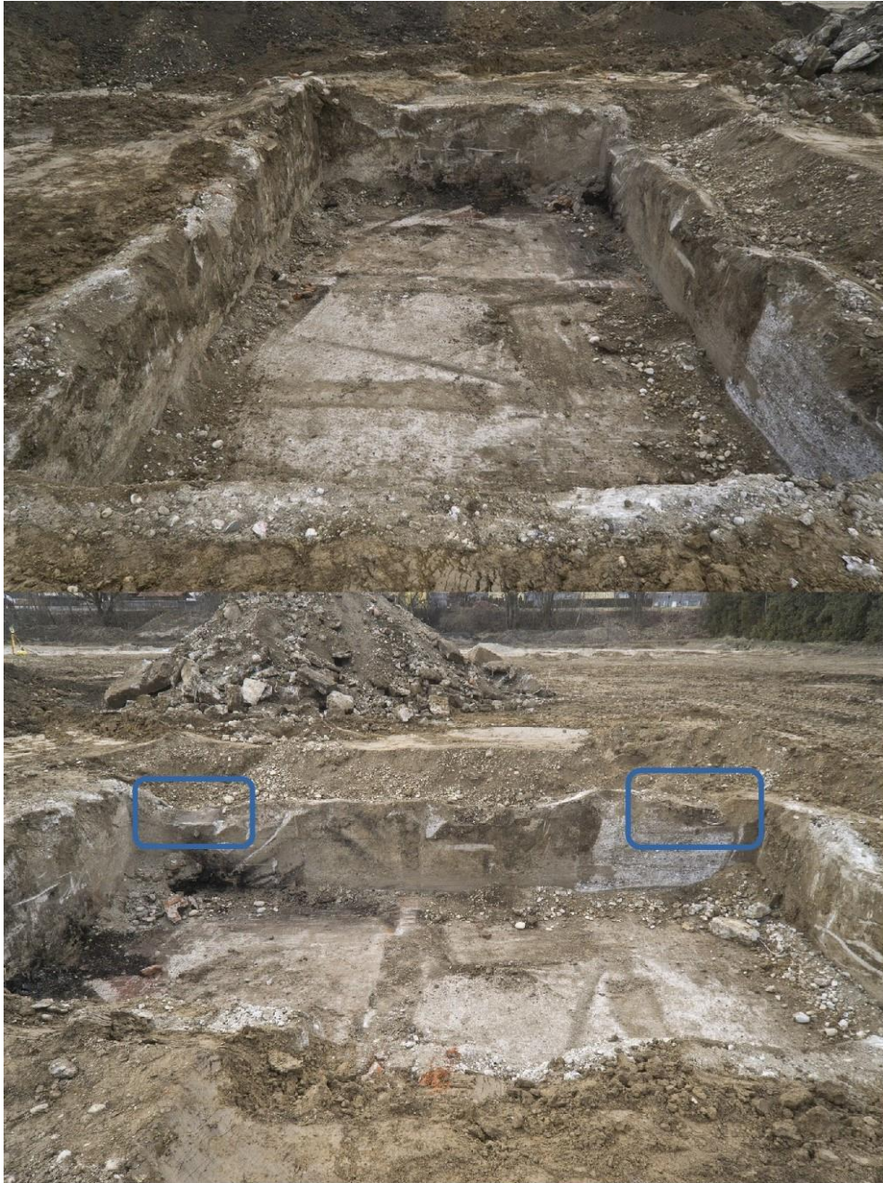
Abbildung 6: deutlich erkennbar in den Fundamenten des Kellers sind die ausgebrochenen Wände, die den Keller einst in drei Räume teilten, wobei der südliche Raum den größten darstellte. Kohleschütte (links im Bild) und Treppenzugang (rechts im Bild) wurden farbig markiert. Oben: Ansicht von Nord, Unten: Ansicht von Osten. ©X-Cavate Archaeology
