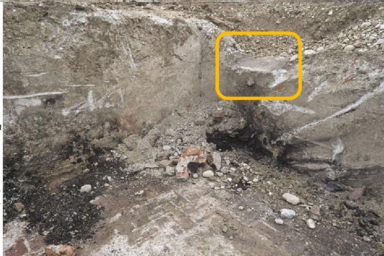
Abbildung 9 Detailaufnahme der teilweise verrußten und mit einer bitumenartigen Substanz überzogenen Kellerwände im Südraum. Über dem Ziegelboden der Räume war ein Estrich ausgebracht worden. In der südwestlichen Ecke fanden sich noch die Überreste von schollenartig zusammenklebenden Bitumen- oder Teerresten sowie Teile eines gemauerten Kamins. Oberhalb in der gleichen Ecke sind die Reste der postulierten Kohleschütte erkennbar (gelb). Insgesamt könnte es sich hierbei um einen Heizungsraum gehandelt haben. ©X-Cavate Archaeology
