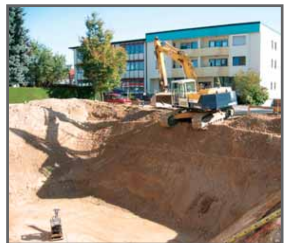
Ausheben der Baugrube im Oktober 2006
