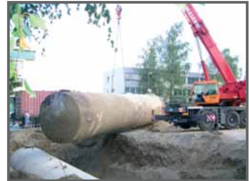
Ausbau von zwei 100.000 Liter Heizöltanks im September 2006
