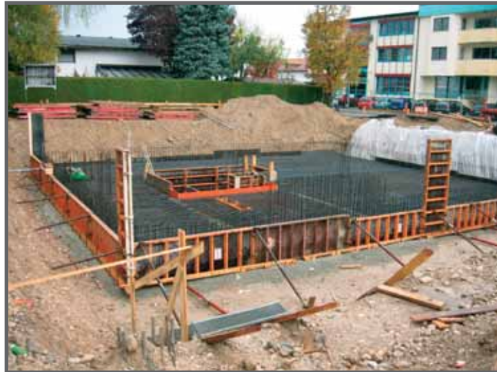
Betonieren des Kesselfundaments im Oktober 2006
