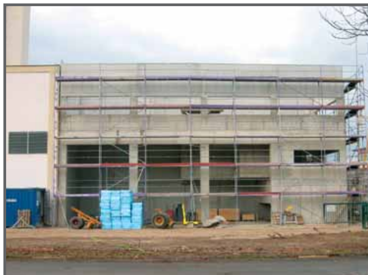
Baustand im Februar 2007 - Südansicht zum Tagesbunker für Hackschnitzel
